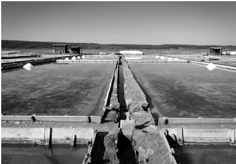
Slika 4: Dovodni kanal, lida , na solinarskem fondu (vir: Maja Bjelica, osebni arhiv)
