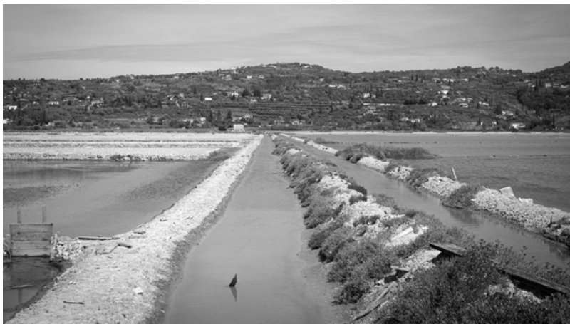
Slika 3: Zbirni in dovodni kanal za območje 2. izhlapevanja (desno), ki ga razmejujeta od območja 3. izhlapevanja (levo) (vir: Maja Bjelica, osebni arhiv)
